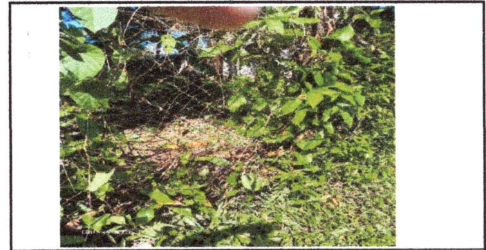
Foto 6: Malla oxidada y en mal estado
