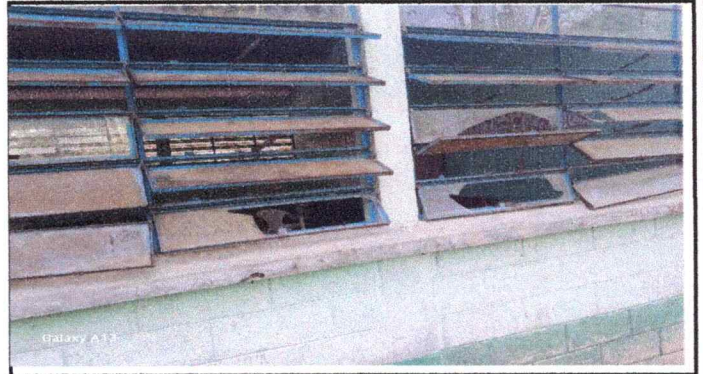
Foto 2: Mantenimiento de ventanas y vidrios en el módulo 2 y 3.
